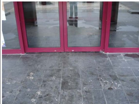
Photo 6: seuil praticable, sans différence de niveau, portes automatisées
