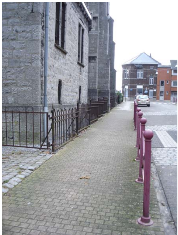
Photo 2: largeur de trottoir > 1,50 m. et barriers de sécurité.
