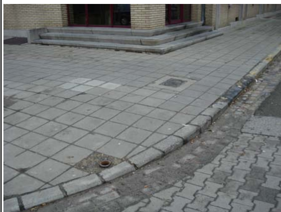
Photo 5: Trottoirs sans inflexions, trop saillants, et peu visibles
