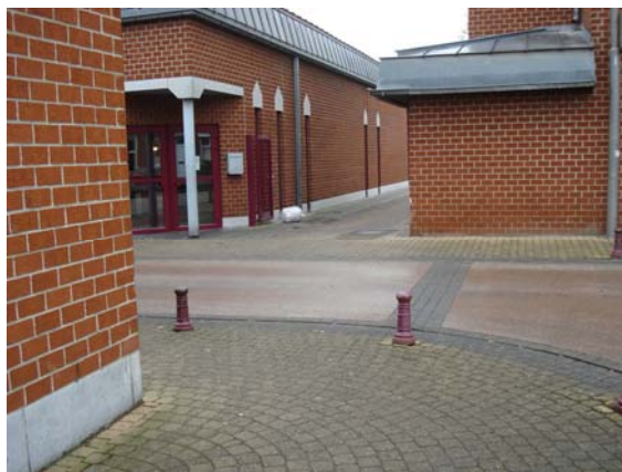
Photo 1: vue de la Salle du Préau, du coin de la Maison de l'emploi.
