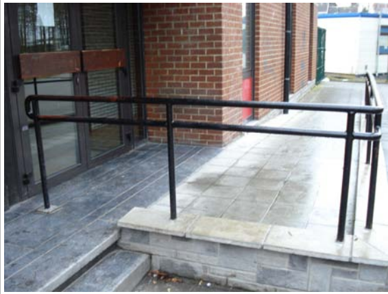
Photo 7: Rampe d'accès, et seuils praticables
