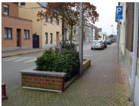
Photo 6: Stationnement PMR derrière le bac à fleurs.
