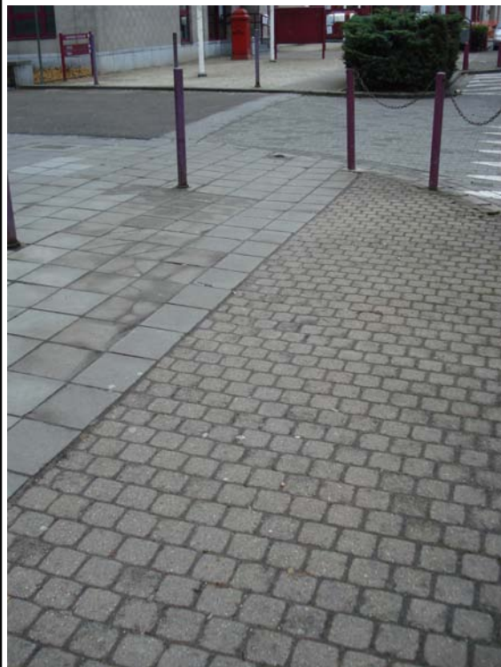
Photo 3: Raccord des différents pavages devant
