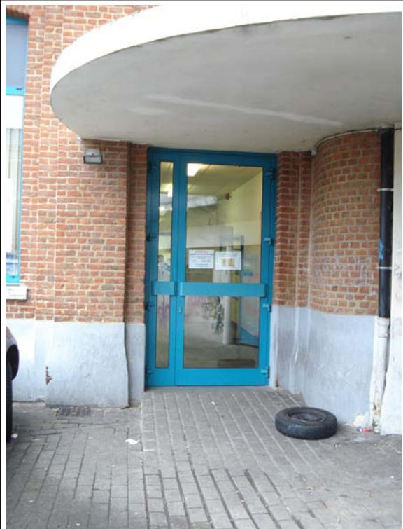
Photo 2: Entrée de la bibliothèque avec rampe d'accès
