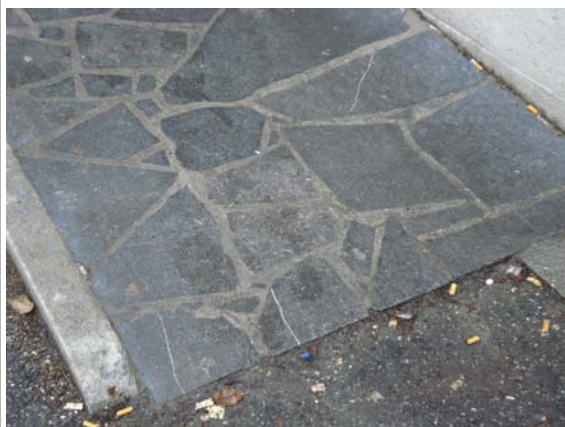
Photo 5: Raccord entre le tarmac et la rampe d'accès
