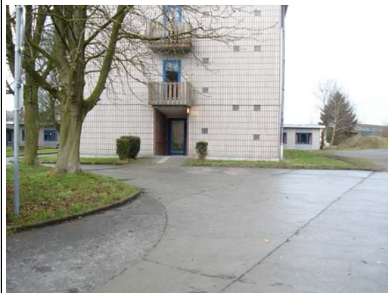
Photo 1: accès N°2 au parking.
