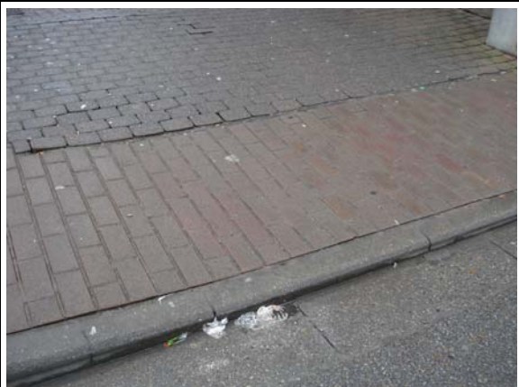
Photo 2: bodure d'accès de la voirie vers le parking.
