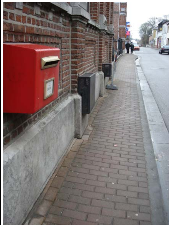
Photo 3: largeur de trottoir <1,50m., obstacles et forte inclinaison du sol.
