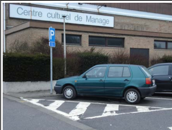
Photo 1: Stationnement PMR à 30m de l'entrée principale
