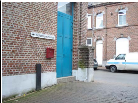
Photo 5: Seuil impraticable pour l'accès lateral.
