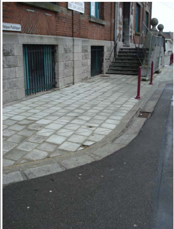
Photo 4: Accès par deux escaliers symétriques à l'entrée en hauteur
