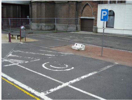
Photo 3: emplacement de parking pour PMR
