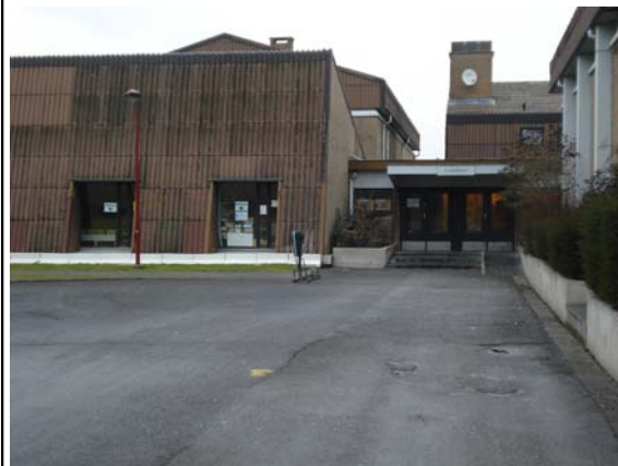
Photo 3: Vue de l'entrée du stationnement PMR
