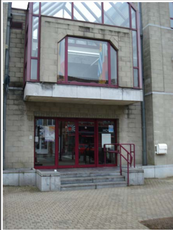
Photo 1: entrée avec rampe d'accès de 2%
