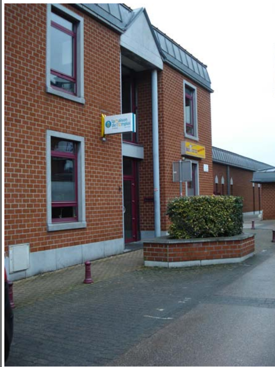
Photo 1: Maison de l'emploi.
